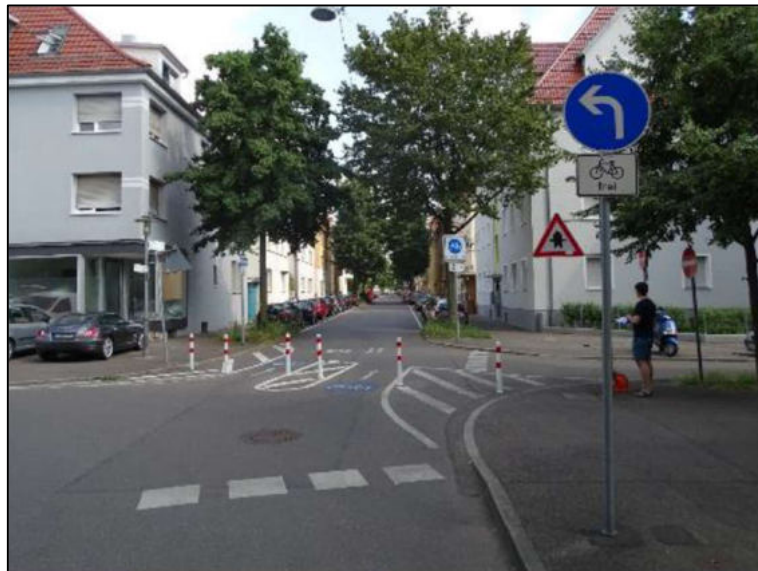
Bild 6: Beispiel einer Diagonalsperre 12
