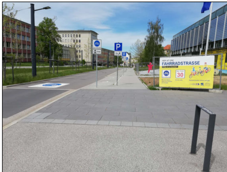
Bild 9: Fahrradstraße Reichenhainer Straße 17
