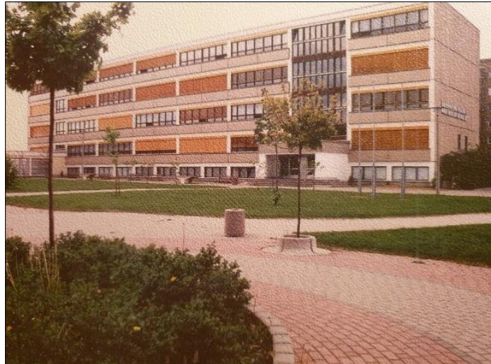
Abbildung 8: Gebäude der Oberschule „Gottfried Pabst von Ohain“ 116
