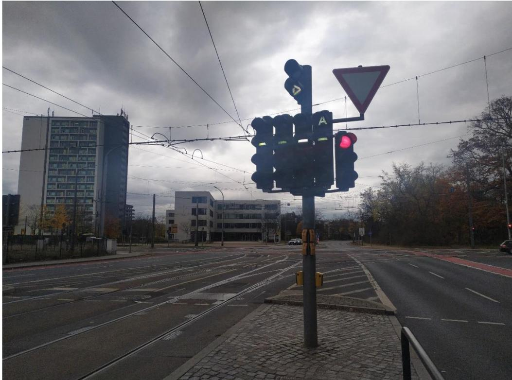
Abbildung 4: Optische Rückkoppelung der Anmeldung zum Rechtsabbiegen durch ein "A" und das Weichenstellsignal nach rechts (eigene Aufnahme)
