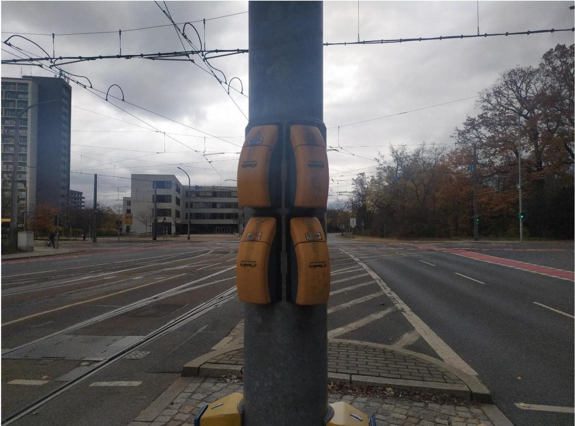
Abbildung 5: Schlüsselkontakte am Lennéplatz mit 4 möglichen Ausfahrrichtungen (eigene Aufnahme)
