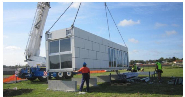
Abbildung 5: Aufstellen eines SmallHouse auf Punktfundamenten [70]
