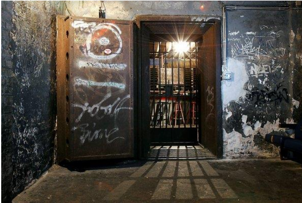
Abbildung 3 – Alte Stahltür im Klub Tresor
